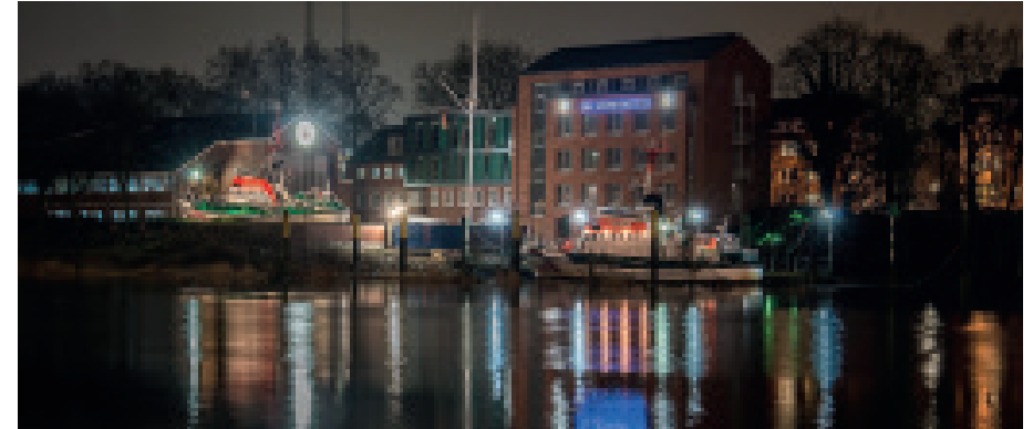
Zentrale der Seenotretter am Weserufer in der Bremer Innenstadt mit Werfthalle, SEENOTLEITUNG BREMEN (MRCC = Maritime Rescue Co-ordination Centre) und Seenotküstenfunkstelle BREMEN RESCUE RADIO
