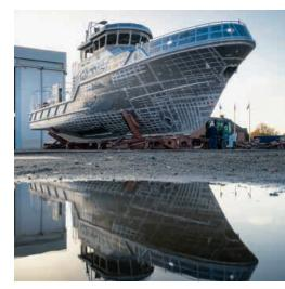
Ende Oktober 2020 sind Rumpf und Aufbauten zusammengebaut – aus 9.640 Aluminiumteilen – 35 x 35 mm bis 7,89 m x 62,8 cm groß und zusammen allein 35 Tonnen schwer.
